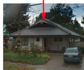
Wird verwendet, um ein Dach mit holländischem Giebel zu erstellen
