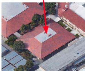
Wird verwendet, wenn ein geneigtes Bauwerk einen flachen oberen Abschnitt anstelle eines Firsts hat
