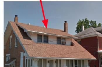
Dachgaube mit einer Schräge
